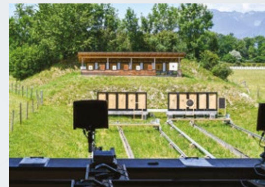
Stand intercommunal de Saint-Triphon
